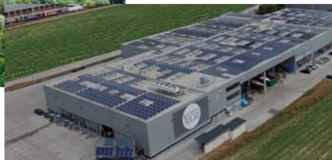
Kioto Solar + GREENoneTEC üzemsarnok 1,1 MW
