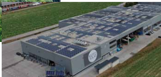
Kioto Solar + GREENoneTEC üzemcsarnok 1,1 MW
