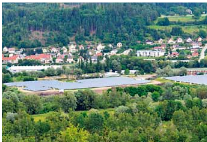
Hulladék lerakó telep 2 MW
